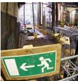
Baugrube für die Nord-Süd-U-Bahn am Kölner Heumarkt. (Bild: dpa)
